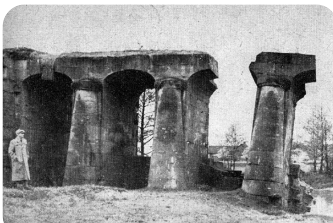
Zapora w Brodach po powodzi w 1903r
