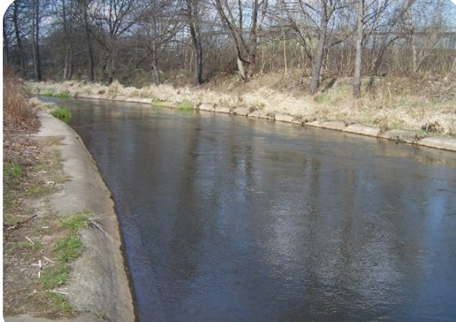
Uregulowana rzeka Kamienna na wysokości Zakładu Metalurgicznego
