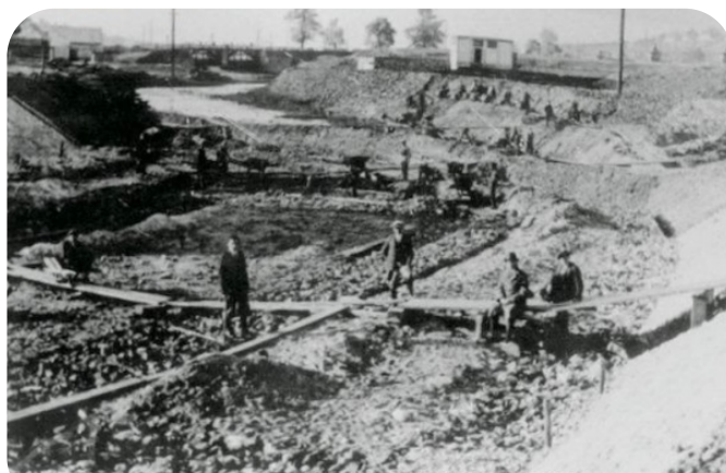
"Początek prac przy regulacji rzeki Kamiennej. W oddali widać upust zalewu „Pasternik”"
