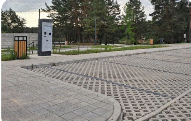
Nowy parking nad Zbiornikiem Lubianka
