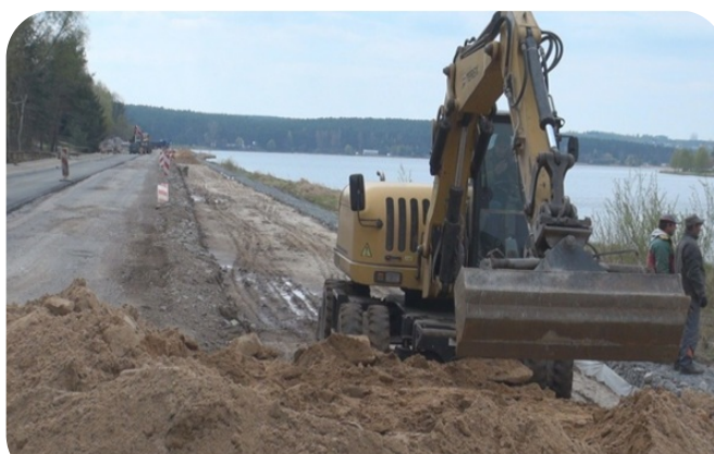
Zagospodarowywanie terenów wokół zalewu Brody
