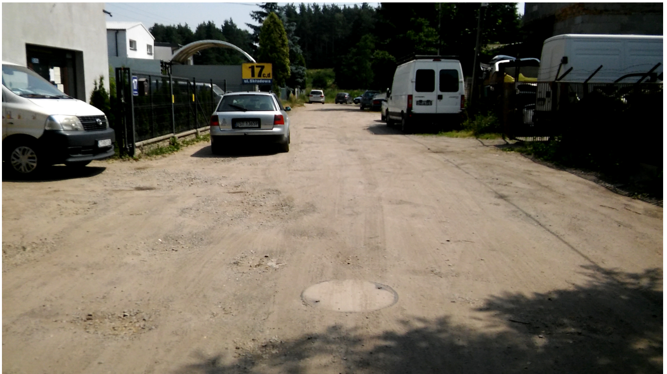
Odcinek ul. Składowej przed inwestycją...
